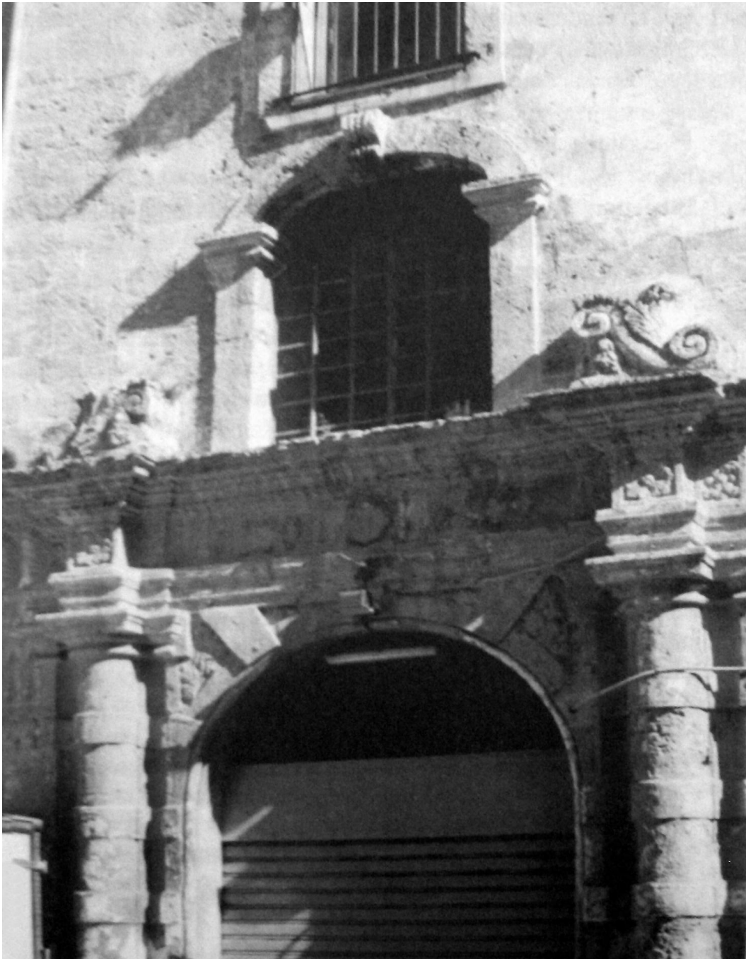
Fig. 47. Portale d'ingresso dell'ex residenza dei Gesuiti in Via Amalfitana (da Moccia, 2003).
