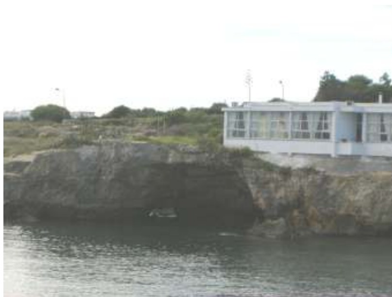
Foto n. 19 - Dissesti per crollo in rocce non particolarmente fratturate.
