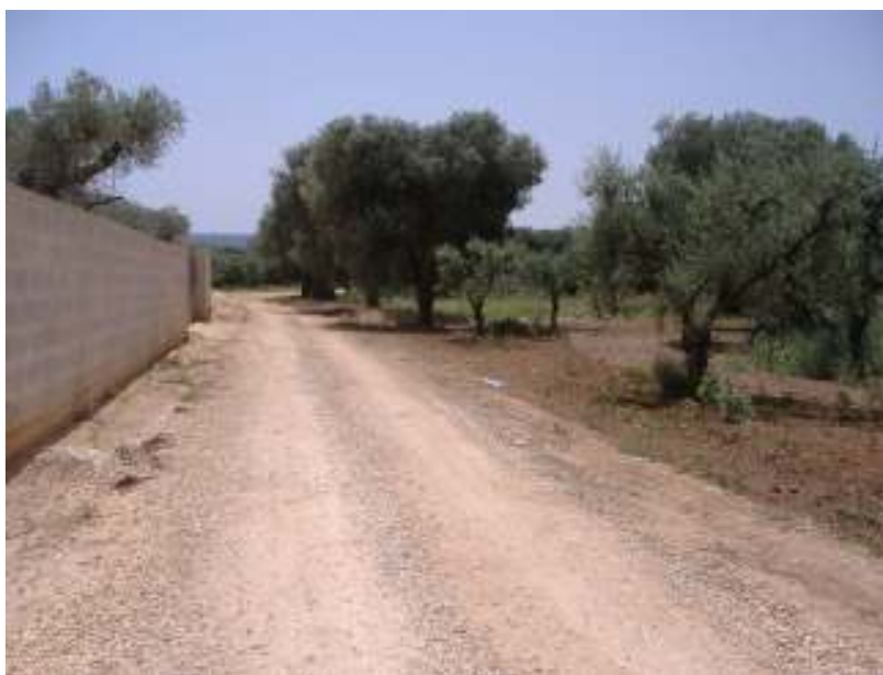
Foto n. 12 - Lama S. Vincenzo: il muro di recinzione ostacola il deflusso delle acque.
