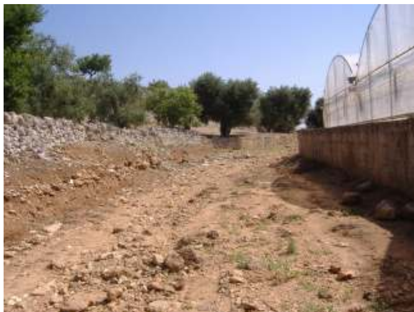
Foto n. 9 – Alveo di Lama Don Angelo ridotto in larghezza dal muro a difesa delle serre
