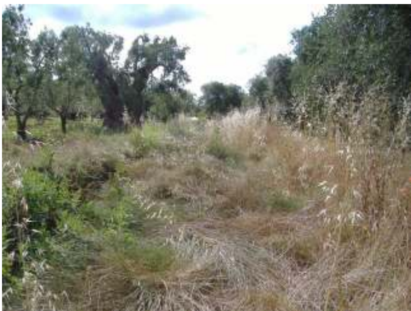
Foto 4 - Tratto di lama interrata a monte del tombino sotto la S.P. Monopoli-Alberobello
