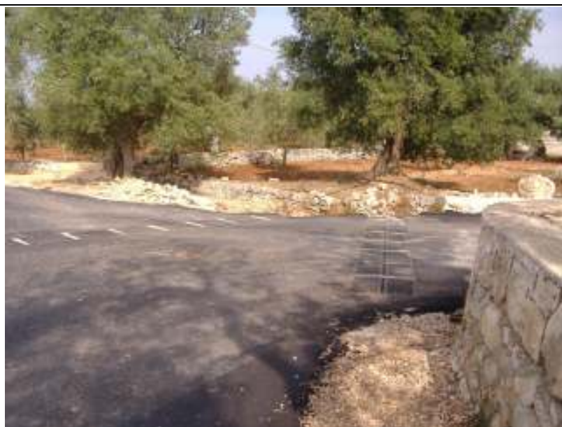
Foto n. 17 – S. C. Rizzitello dove le acque sono intercettate da caditoie realizzate di recente
