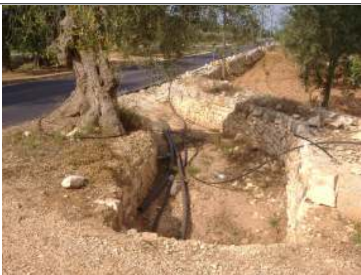
Foto n. 16 – Le acque piovane intercettate dalle caditoie affluiscono nel canale laterale lungo pochi metri e poi scorrono sulla S.C. Rizzitello
