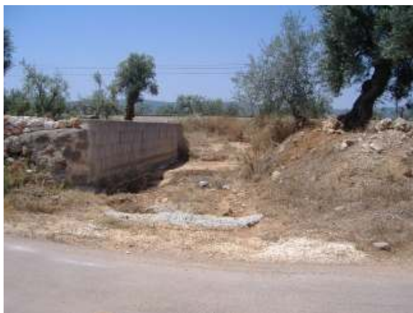
Foto n. 11 - Canale naturale che sbocca sulla S.C. S. Procopio
