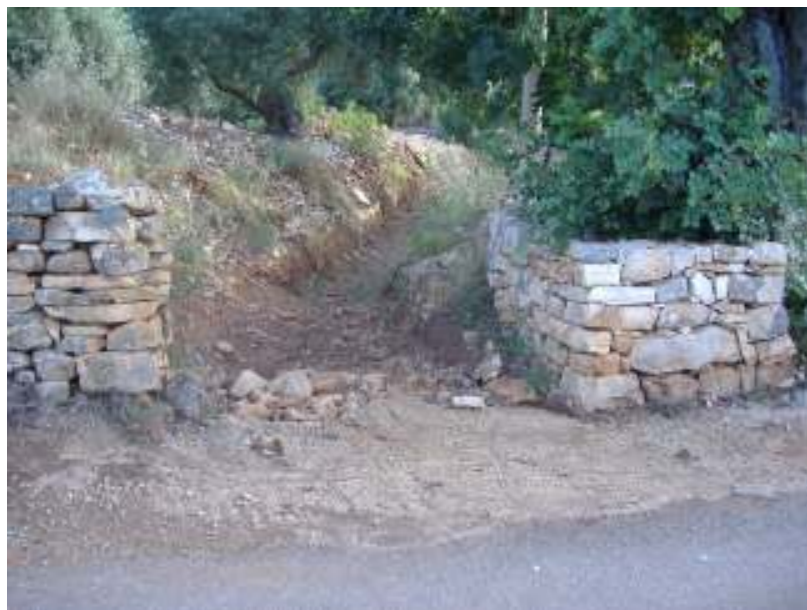
Foto n. 10 - Canale naturale che sbocca direttamente sulla S.C. S. Oronzo
