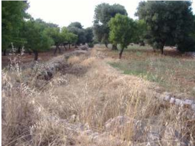
Foto n. 8 – Canale colmo di detriti vicino l'incrocio S.C. Cristo delle Zolle e S. C. Guidano.
