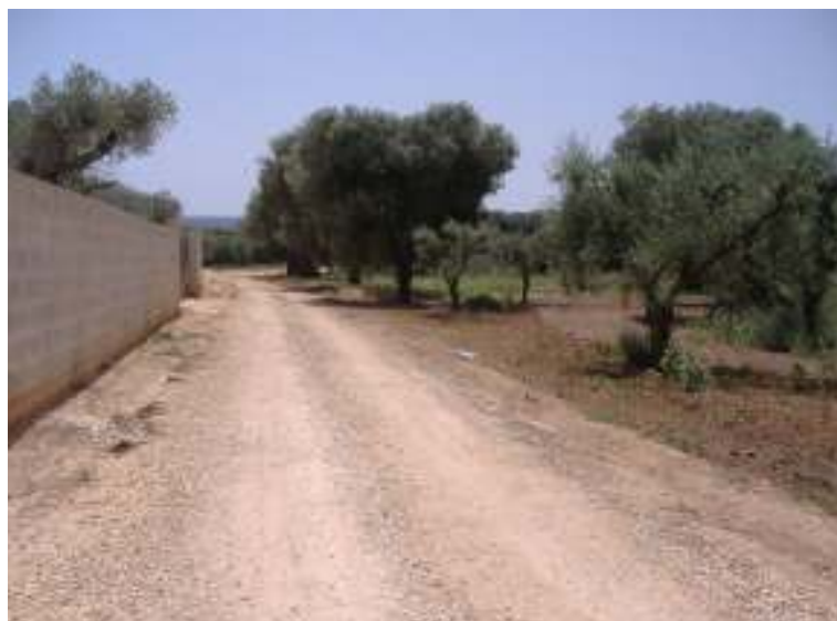
Foto n. 12 - Lama S. Vincenzo: il muro di recinzione sbarra il deflusso delle acque.
