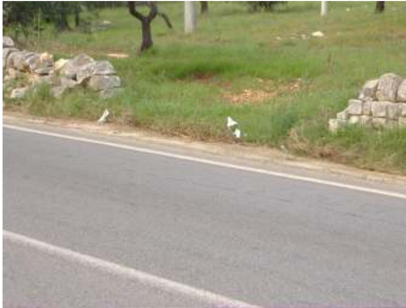
Foto 1 –Sbocco del torrente sulla sede stradale della S.P. Monopoli – Castellana
