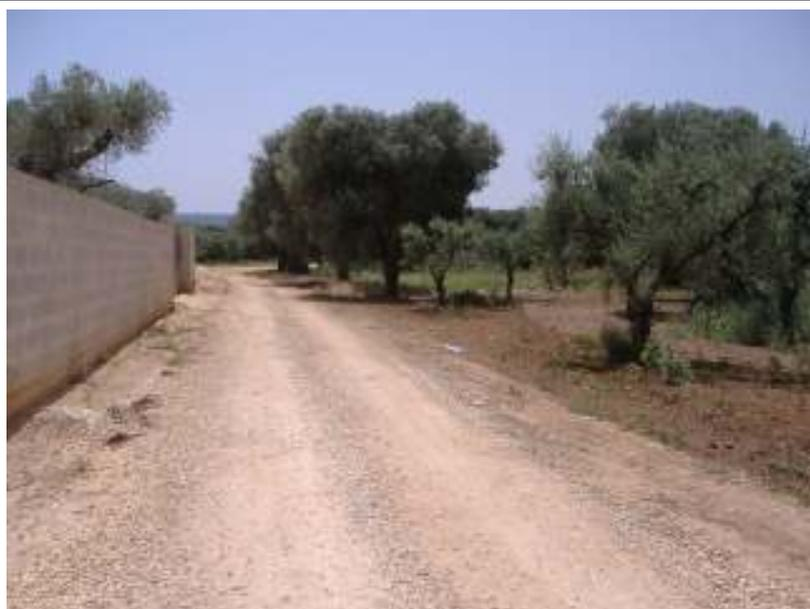
*Foto n. 12 - Lama S. Vincenzo: il muro di recinzione ostacola il deflusso delle acque.*
