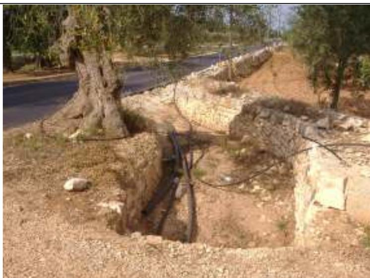
*Foto n. 16 – Le acque piovane intercettate dalle caditoie affluiscono nel canale laterale lungo pochi metri e poi scorrono sulla S.C. Rizzitello*
