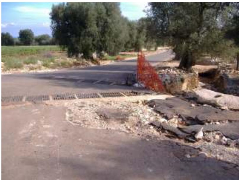
*Foto n. 18 – S. C. Rizzitello: il nuovo asfalto scalzato dalle acque piovane dilavanti*
